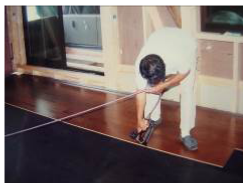
フローリングの釘留め
