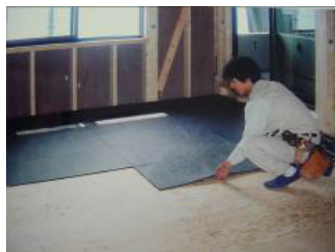
AOI ショーオンボード敷設中
