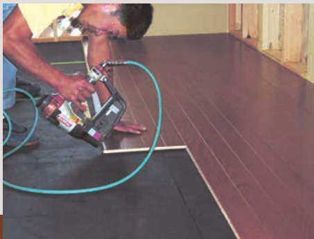
フローリングの釘留め
