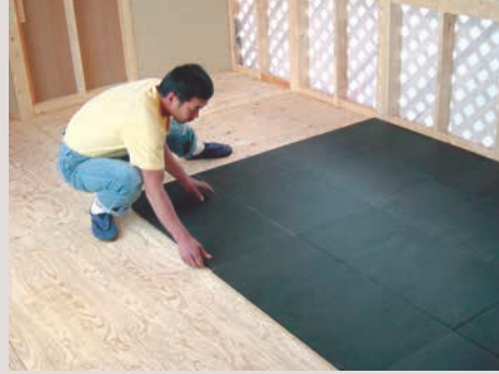
AOIショーオンボード 敷設中
