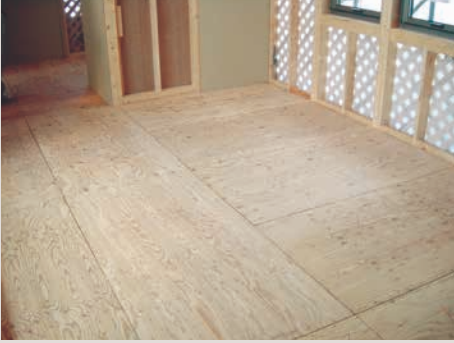
AOIショーオンボード 敷設前
